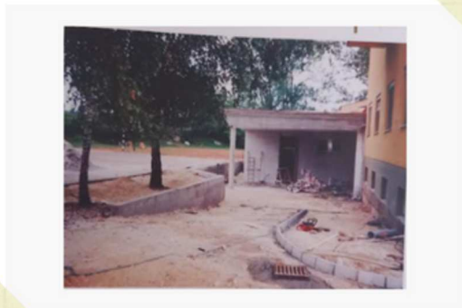
Pričetek gradbenih del prizidka
